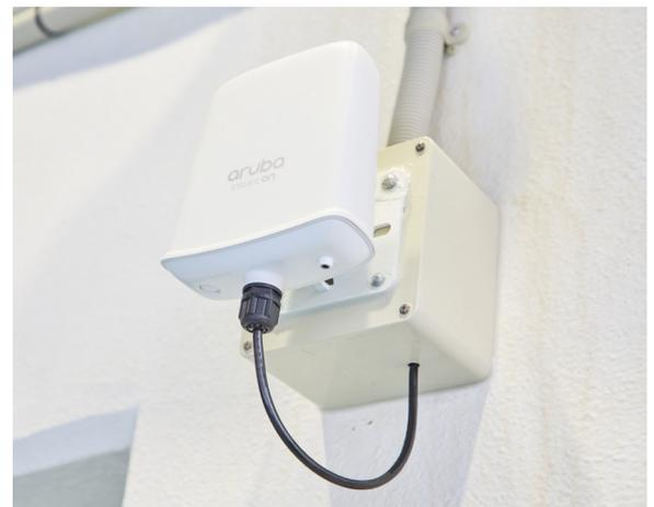
Aruba Instant On AP17。取付部の腐食にも配慮して設置してある
